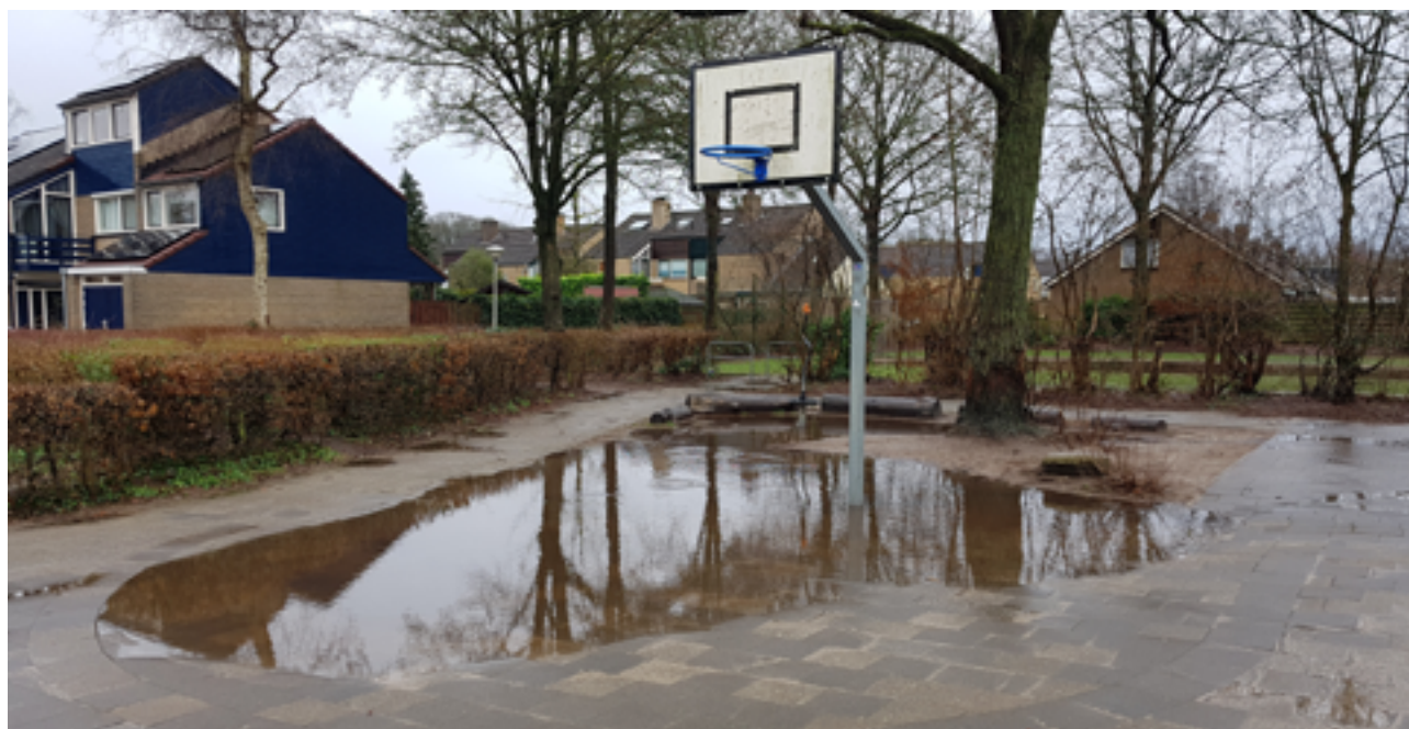
Regenwateropvang in verdiept aangelegd basketbalveldje bij basisschool De Rythmeen in Bathmen. Beeld: Anneke Rodenburg
